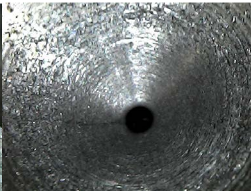
2 pav. Restauruoto vožtuvo lizdo paviršius
