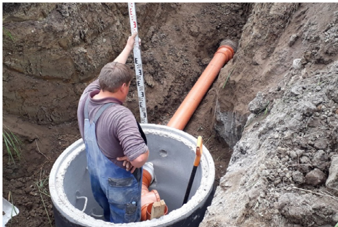
3.4 pav. Esamas rinktuvas prie šulinio prijungiamas neperforuotais vamzdžiais
