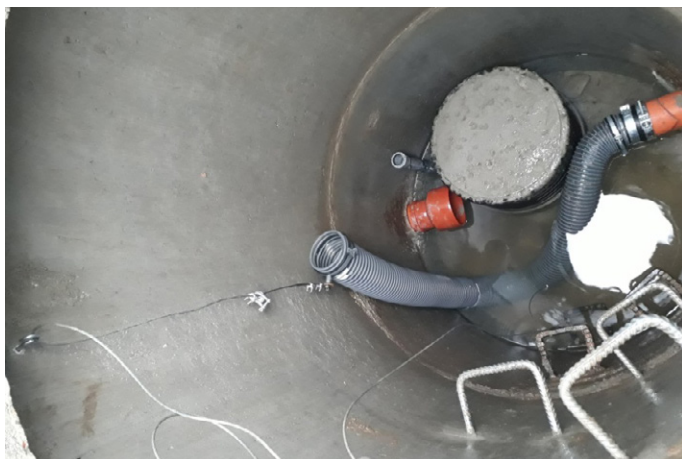
3.5 pav. Vandens lygio reguliavimas lankščiu vamzdžiu
