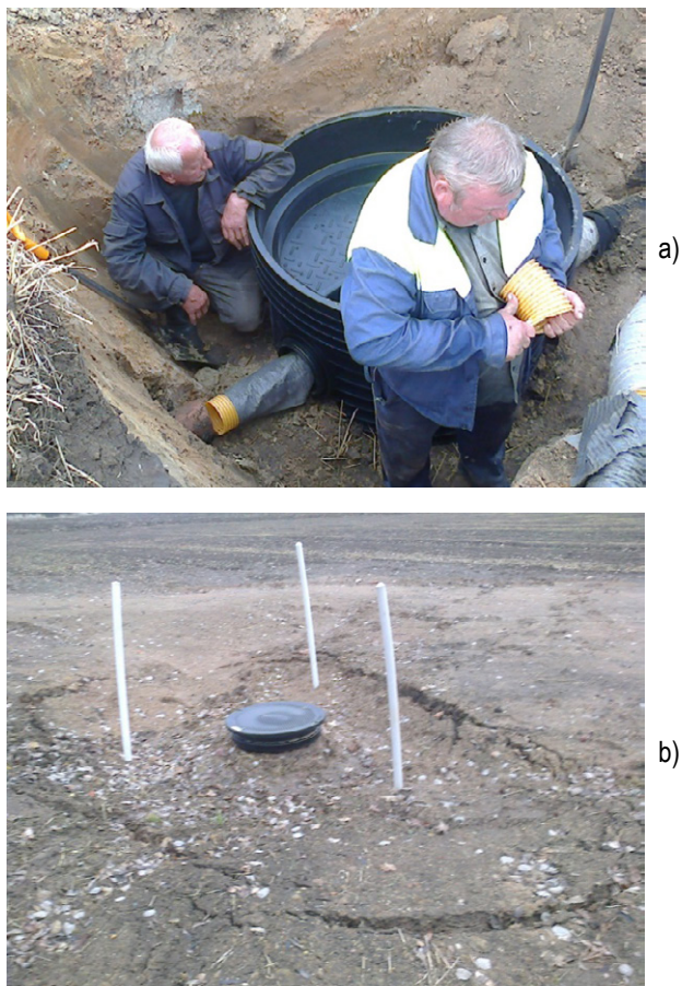
7.1 pav. Netinkamai atliekamas drenazo rinktuvo prijungimas prie nuotėkio reguliavimo šulinio (a). Pavasarį nusėdęs gruntas liudija, kad nuotėkio reguliavimo šulinys įrengtas netinkamai (b).
