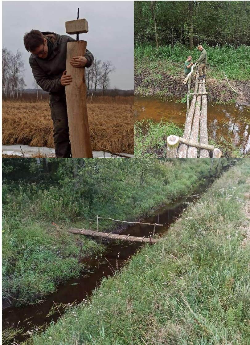
2 pav. Stulpinių laižyklų atnaujinimas, naujai pastatyti liepteliai.
